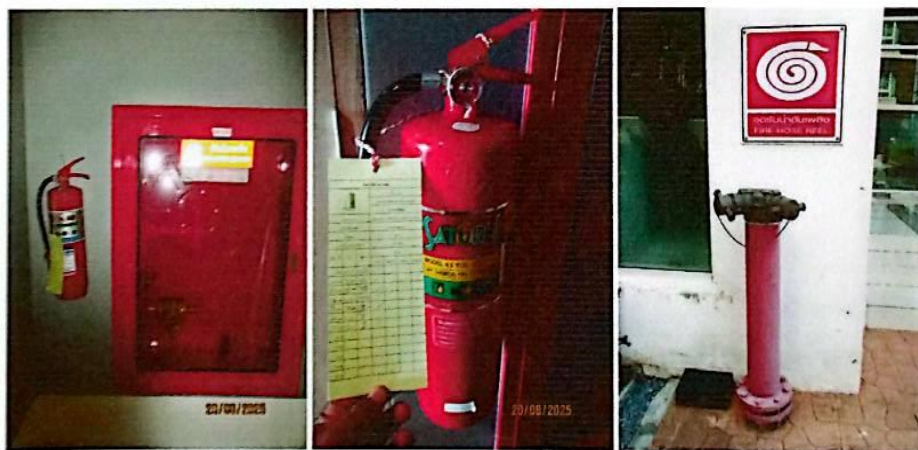
รูปที่ 5 แสดงอุปกรณ์ดับเพลิงแบบมือถือ และตู้ดับเพลิง และหัวรับน้ำดับเพลิง
